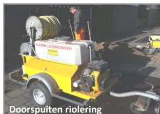
Doorspuiten riolering
