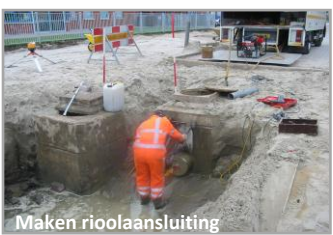
Maken rioolaansluiting
