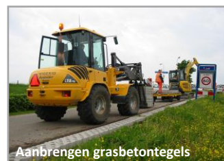
Aanbrengen grasbetontegels
